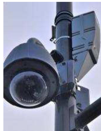
Außenmontage am Mast (mit Kabelschutz)
