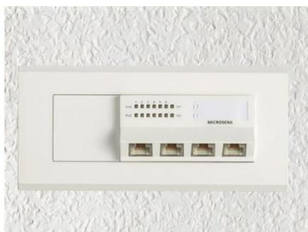
Micro Switch mit Abdeckung montiert in einer Unterputzdose
