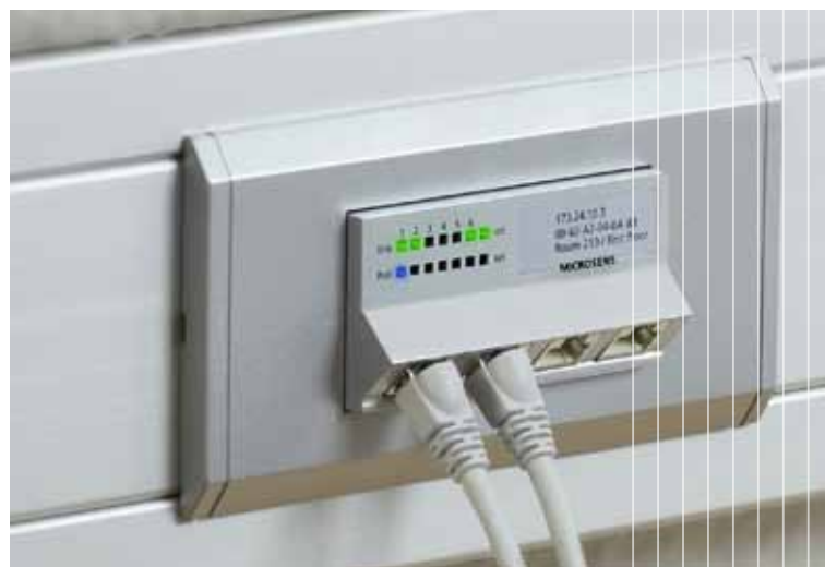
MICROSENS Micro-Switch, eingebaut im Kabelkanal
