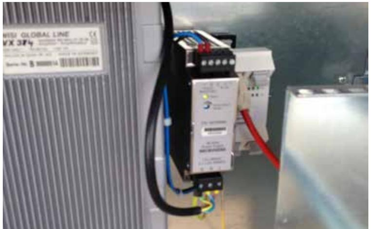
damit, dass zum einen alle geforderten Funktionen im Lieferumfang enthalten waren. Zum anderen punktete der Hersteller mit einem klaren Vorteil bei der Wartung. Die Konfiguration der Switches wird auf einer SD-Karte gespeichert. Muss ein Switch hardwareseitig getauscht werden, kann einfach die SD-Karte in den neuen Switch eingesetzt werden und schon ist er voll funktionsfähig.
